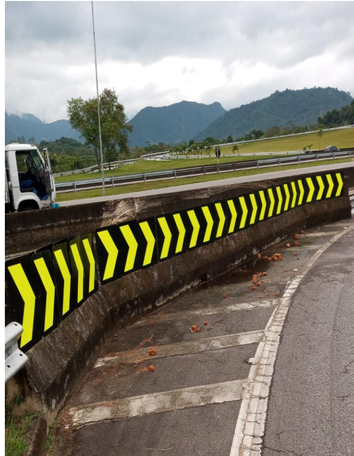
Km 114,9 - P2 - Sinalização vertical
